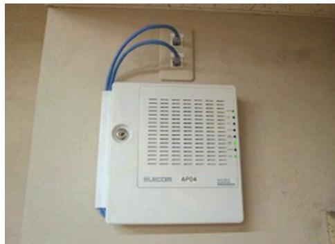
図7 アクセスポイントが設置されたデジ털LANコンセント
