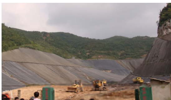
図 4-7 比例堤処分場
