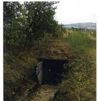
サラエボ空港地下のトンネル 紛争中、安全地帯であるサラエボの南の郊外へセルビア軍に見つからずに出られるように、空港滑走路の真下にトンネルが掘られた。
