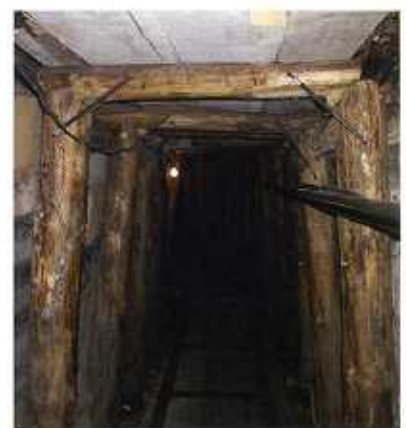
トンネルの中 トンネル内には、トロッキのレールが敷かれて、生活物資や武器の輸送に大きな役割を果たした。中は非常に狭く、高さは1.6mほど。雨が降るとひざまで水浸しになった。
