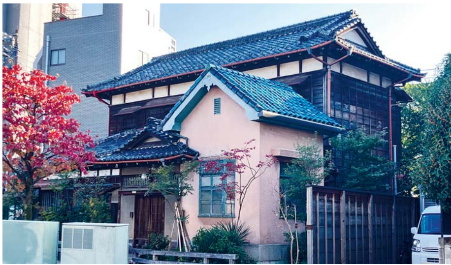
和食板垣の外観
